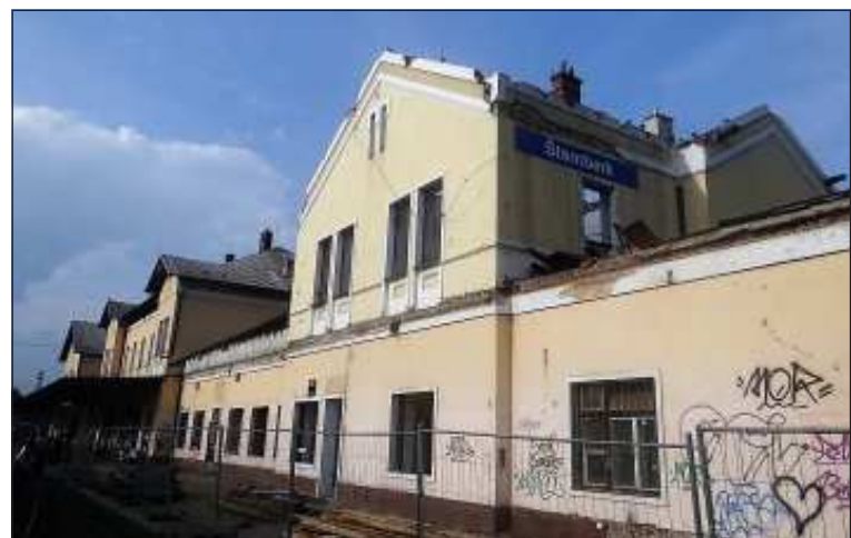
Likvidace části výpravní budovy ve Stermberku již byla zahájena.
