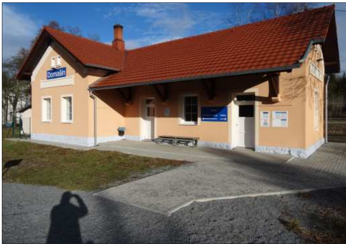
V režii SŽDC byla nedávno opravena budova vlakové zastávky (původně železniční stanice) Domašín. Zámková dlažba dělá z Domašína zastávku koridorových parametrů, jenže až k vlaku zámková dlažba hotova není. Cestující s kočárky se tak musí doslova „brodit“ k vlaku šterkem. Naopak výhodou je zvýšený perón, který tady v minulosti chyběl. Snímek Michael Mareš
