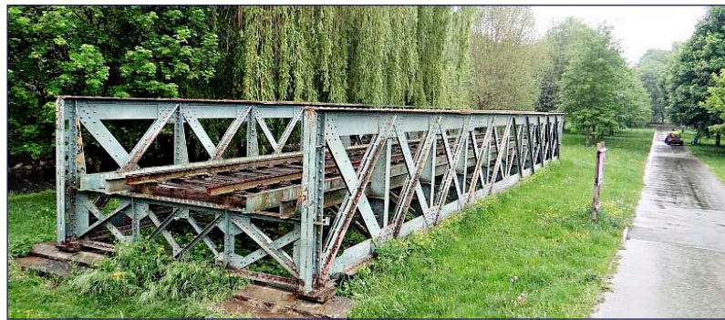
Ježkův most váží 56 tun, na délku měří 24,5 m, na šířku 5,5 m
