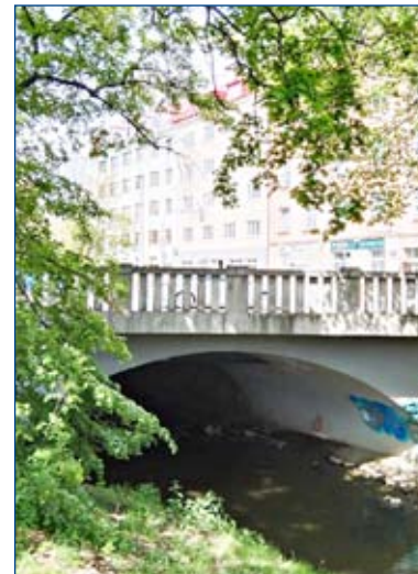
Pod mostem v Sokolovské ulici v Praze protéká Rokytka k sídlu OSŽ
